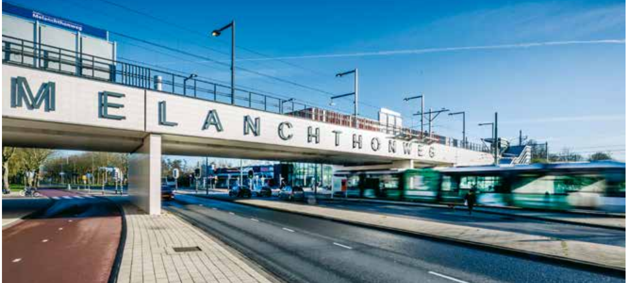
Werkzaamheden Light Rail Koninginnegracht, Den Haag en Mathenesserdijk/Melanchtonweg, Rotterdam
