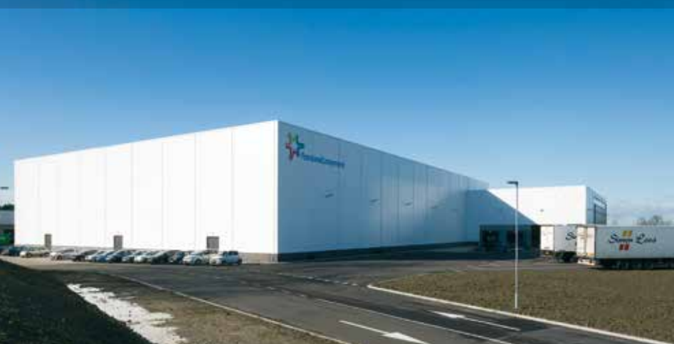
Ontwerp, engineering en projectmanagement distributiecentrum Friesland Campina, Maasdam
